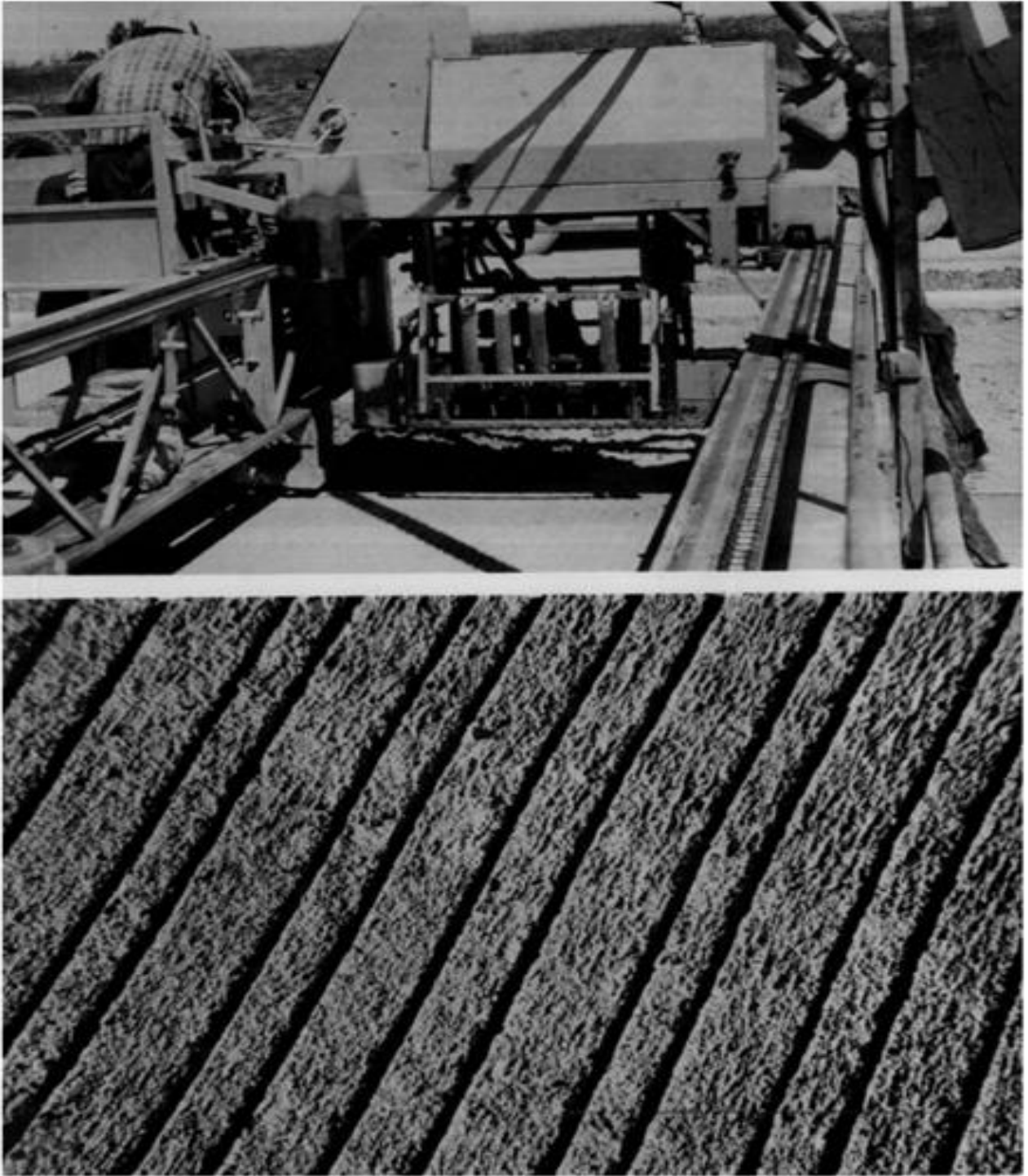
Hình 8 - Kỹ thuật tạo rãnh plastic bằng cách sử dụng vibrating ribbed plate
